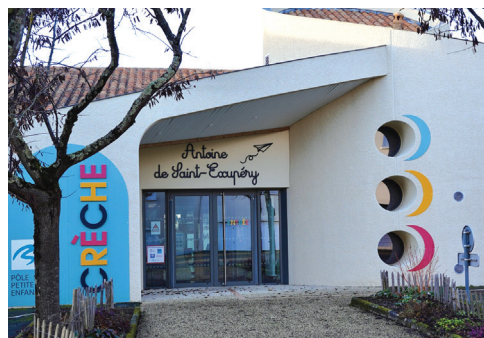
Rénovation de la crèche municipale Saint-Exupéry pour un meilleur confort des enfants et des agents
