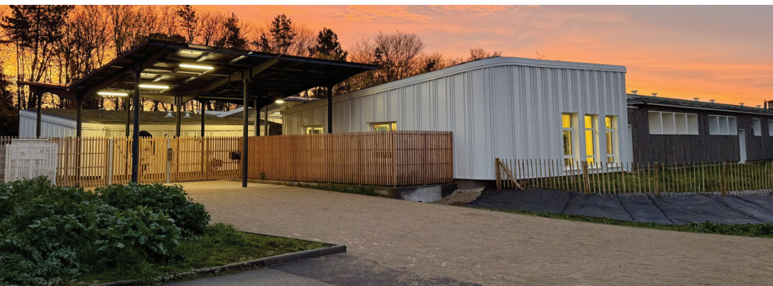
École élémentaire Simone Veil : un bel exemple de rénovation conjuguant utilisation de matériaux écoresponsables et chauffage naturel avec la géothermie
