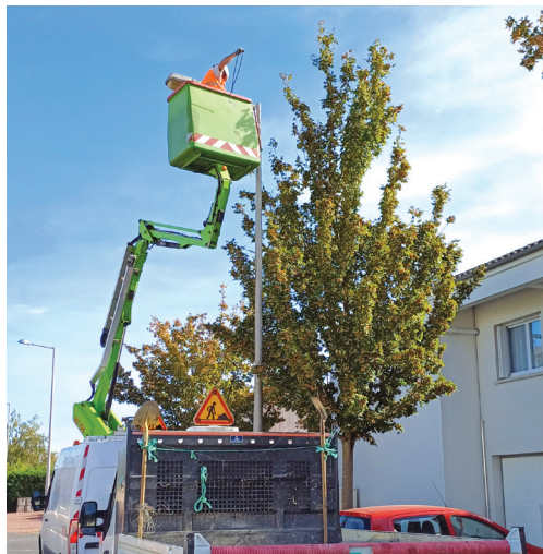
Modernisation de l'éclairage public (passage en LED)
